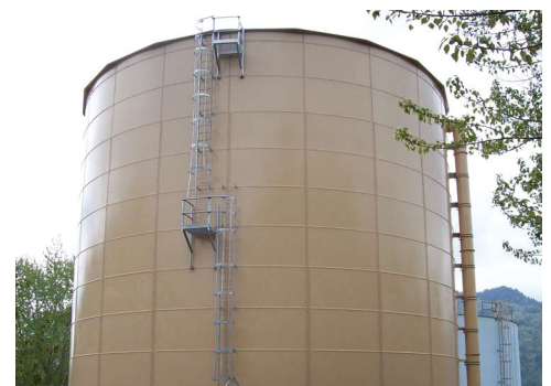
Construcción de RTP - Agua Potable
