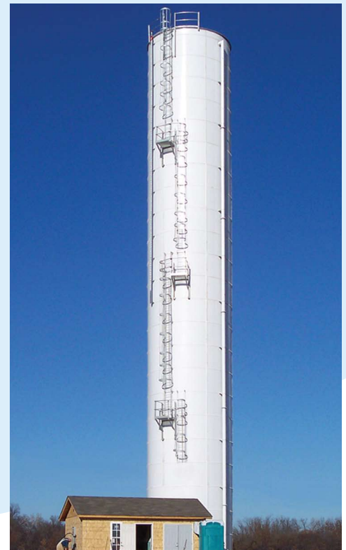
Columna de Alimentación de RTP
