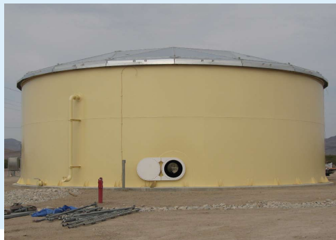
Soldado en Campo con Autógena - Agua Potable
