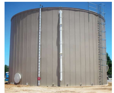
Tanque de Protección Contra Fuego
