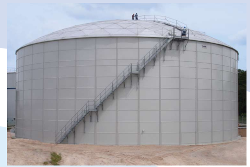
Construcción RTP - Almacenaje de Agua Pura 4.5 Millones de Galones 17.000 de m 3
