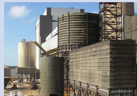
RTP Empernado, Soldado en Campo con Autógena, Soldado en Planta y Construcción Híbrida del Tanque
